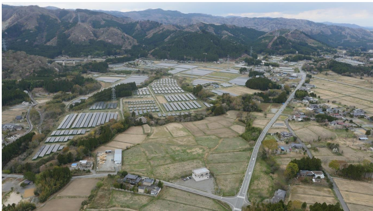
富岡杉内太陽光発電所
