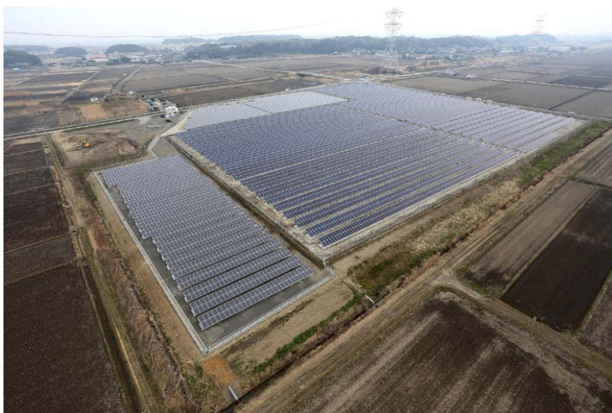
利根町シャープ第二太陽光発電所（左手前及び中央後方部分）
