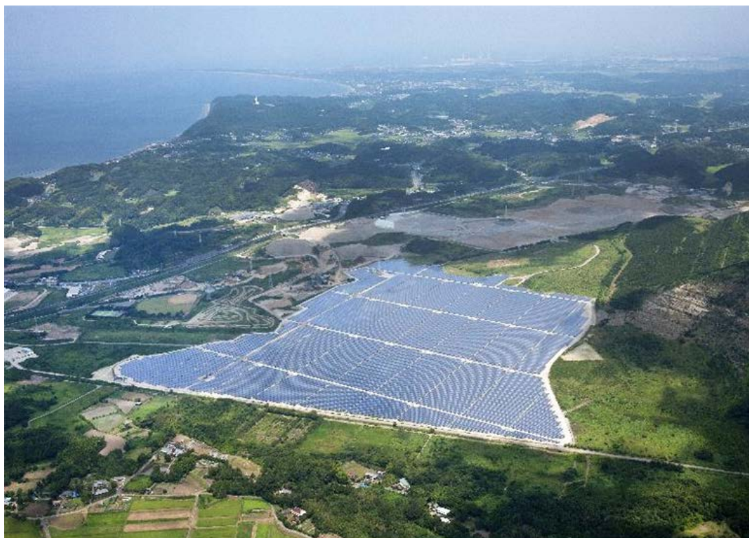
【富津ソーラー発電所 全景】
